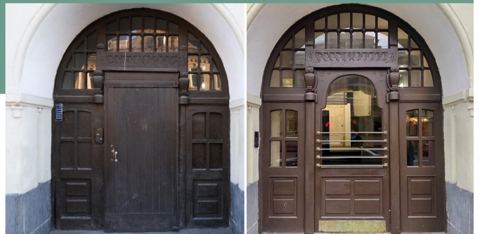
Входная группа парадной №3 в доме Станового: до и после реставрации
