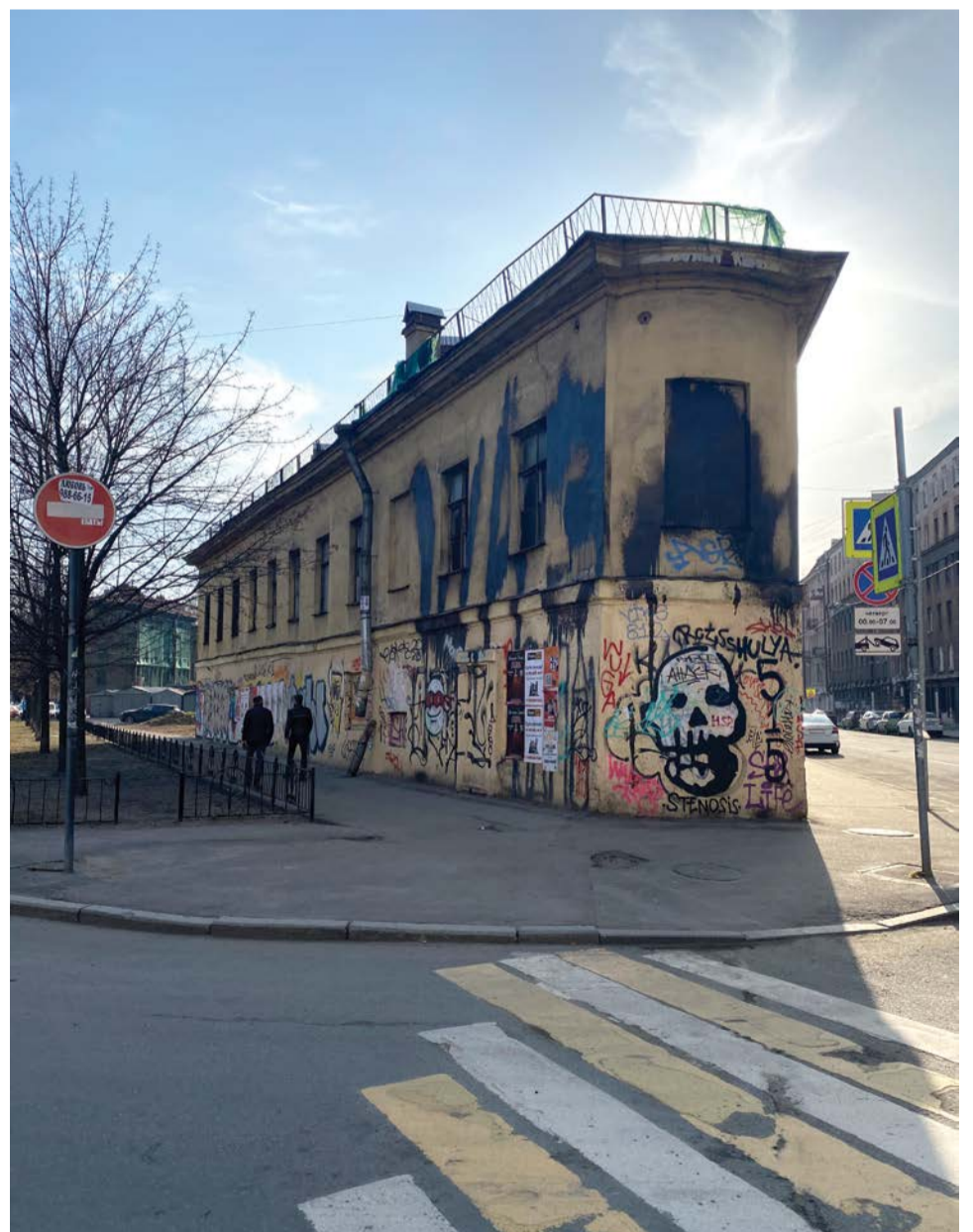
Здание на ул. Константина Заслонова, 8А, которое вдохновило идею проекта «Заслонка». Источник фото: МА МО Владимирский округ
