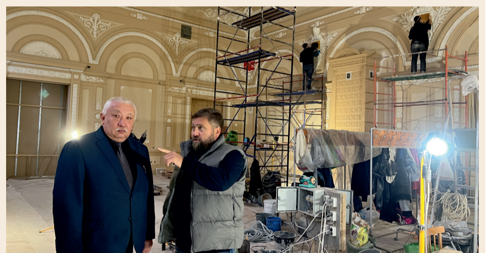
Реставрационные работы близятся к завершению
