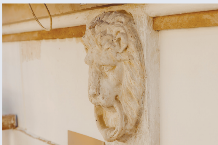
Восстановление 41 маскарона львов, которые украшают фасад Дома Чаплина
